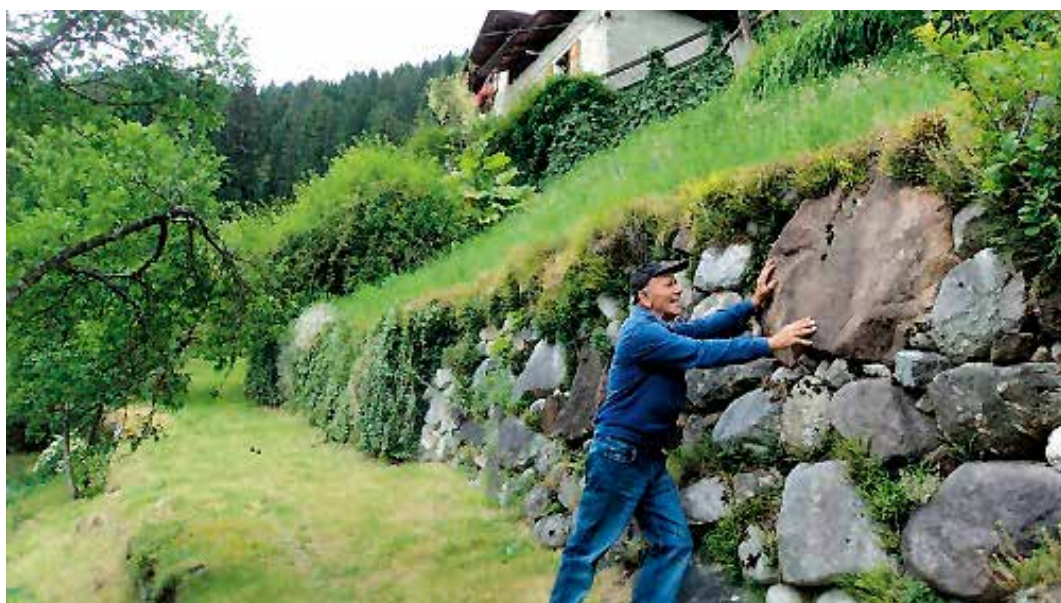
Foto di un muro a secco con massi ciclopici al Maso Vendelin
