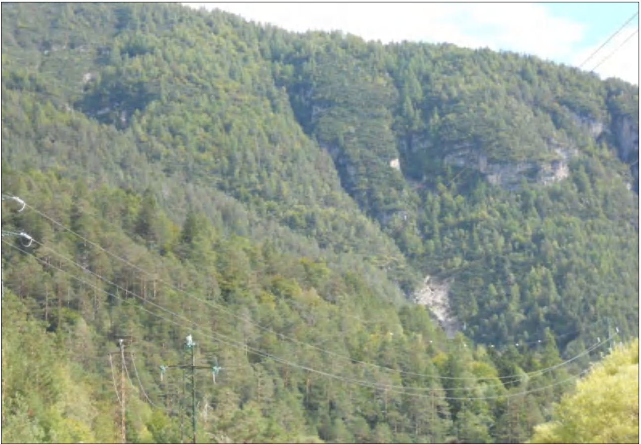
FOTO 10 – S.P. 251. LE LINEE ELETTRICHE POSSONO RAPPRESENTARE UNA POSSIBILE CAUSA D'INNESCO DEGLI INCENDI SOPRATTUTTO QUANDO ATTRAVERSANO TIPI FORESTALI AD ELEVATA POTENZIALITÀ PIROLOGICA
