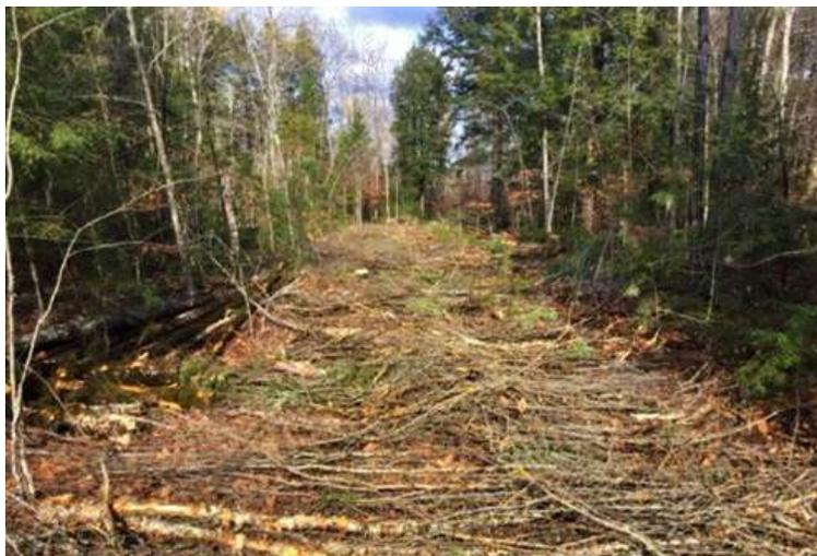
Figura 28: utilizzo dei residui per la diminuzione del compattamento legato al passaggio dei mezzi meccanici.
